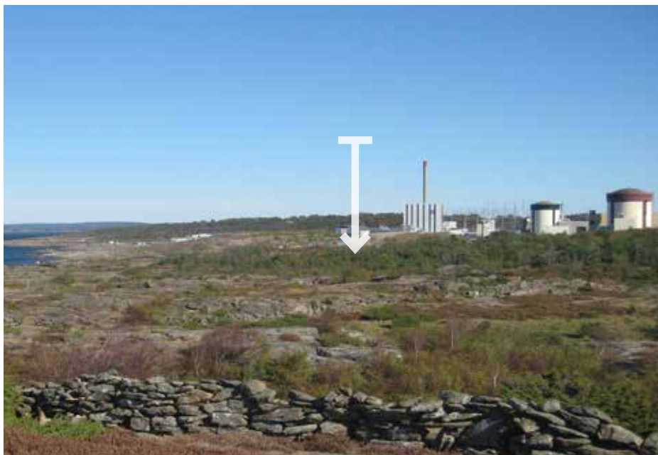
Vid den vita pilen lagras lågaktivt avfall vid Ringhals kraftstation.
