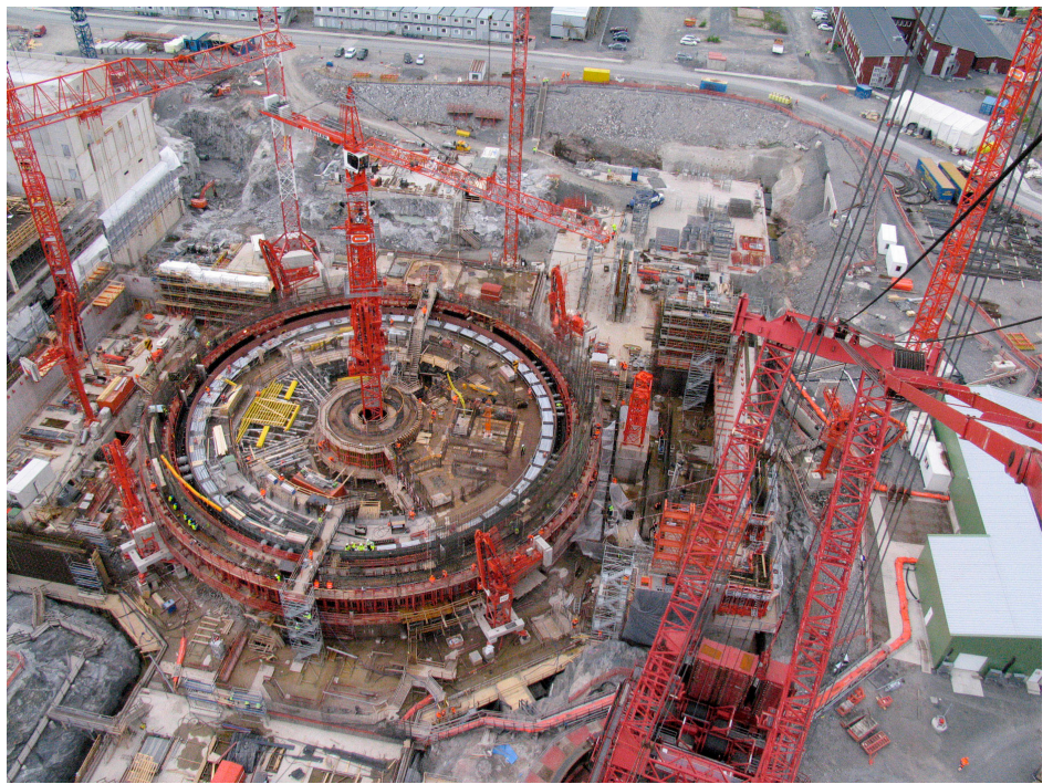
Olkiluoto kärnkraftverk under uppbyggnad, 2007.
